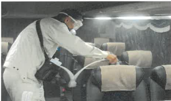
光触媒の施工
